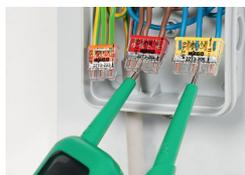
Test possible dans le point de test sur le côté de borne opposé aux entrées de conducteurs
