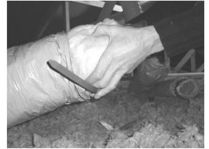
Positionner l'isolant jusqu'à la rainure A
