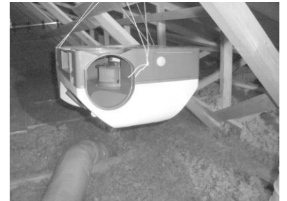
Suspendre le groupe à l'aide la cordelette.
