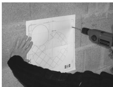
Percer les trous de fixation
