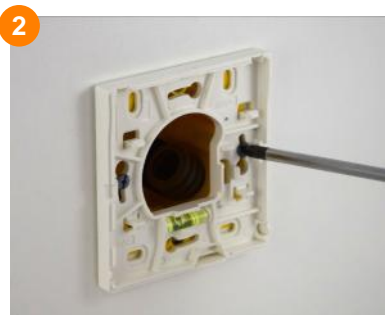
2 Visser la platine (serrer modérément) sur la boîte d'encastrement en respectant le sens haut/bas.
