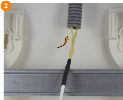
Poser le câble optique dans le conduit à l'aide d'une aiguille de tirage (conduit ø20 mini).
