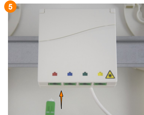
Pour faire les mesures de contrôle ou pour raccorder un appareil au réseau optique, brancher un cordon optique sur une sortie du DT10.
