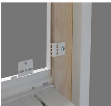
**1.** Placer le cadre de la trappe au dessus du bac, en insérant les barrettes de liaison dans les encoches prévues à cet effet. Verrouiller les pattes à l'aide des vis.
