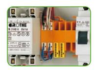
Les supports pour bornes permettent de respecter la norme en rendant fixe la connexion, lorsque cela est nécessaire.
