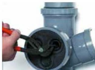
3 - En fonction du nombre et du diamètre des collecteurs sanitaires, retirer à l'aide d'une pince **les opercules du tampon de réduction universel** utiles.
