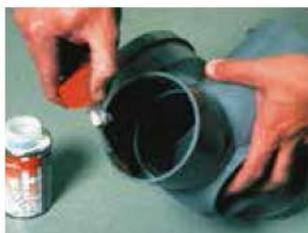
1 - Coller la culotte sur le tube de l'étage inférieur.
