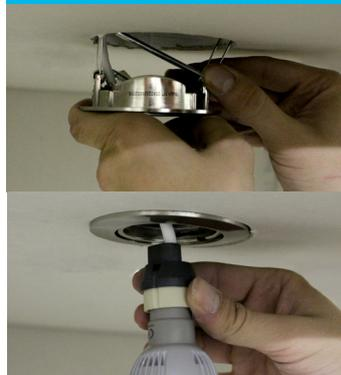
Insérer l'armature du spot et brancher l'ampoule
