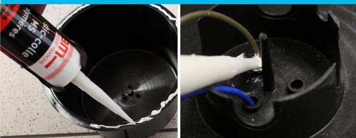
Pour une totale étanchéité, appliquer une ligne de silicone sur le bord et sur les trous de passage de câble du RAMSPOT RT
