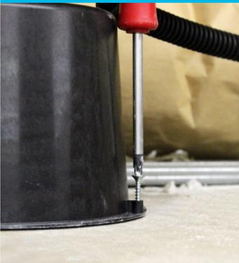
Visser modérément le RAMSPOT RT avec les vis 3x20 incluses (possibilité d'utiliser le joint silicone).
